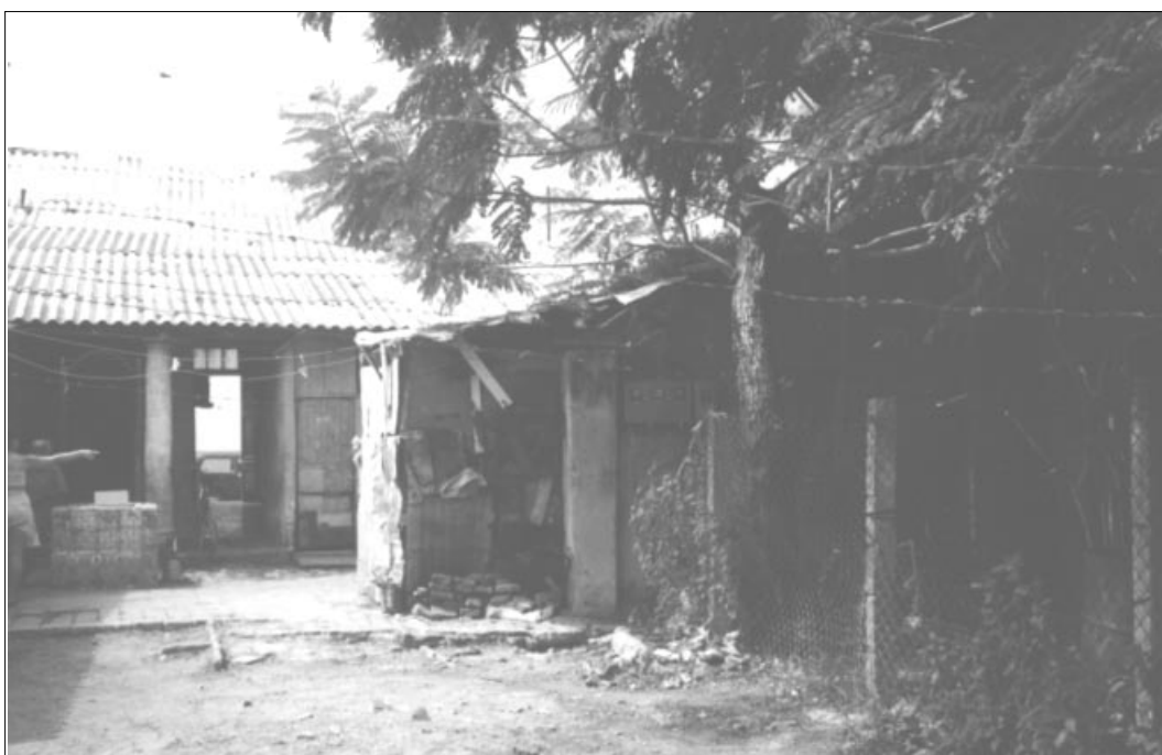
• Estat de les cuarterías
