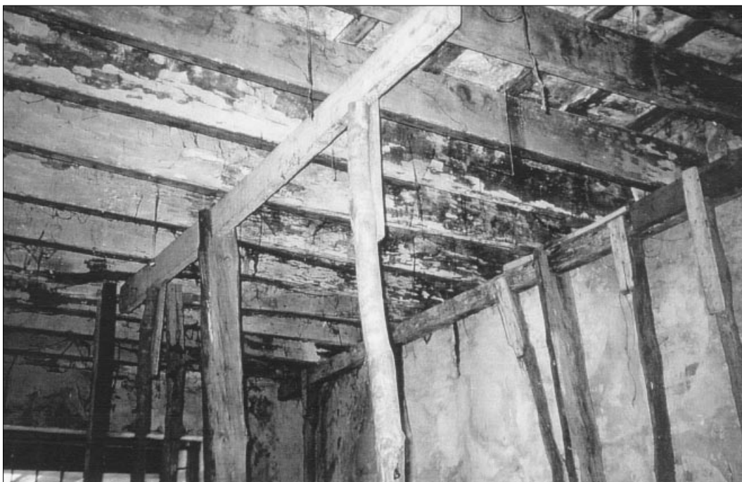
• Estat actual d'un dels habitatges
