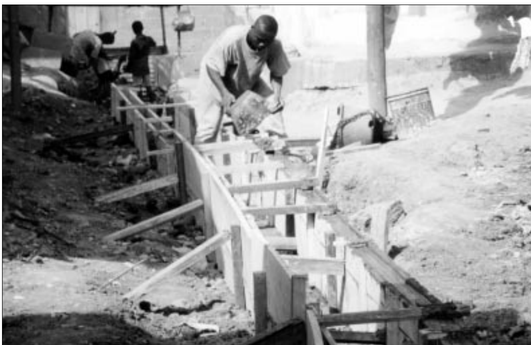
• Preparació per pavimentar un dels carrers del barri
