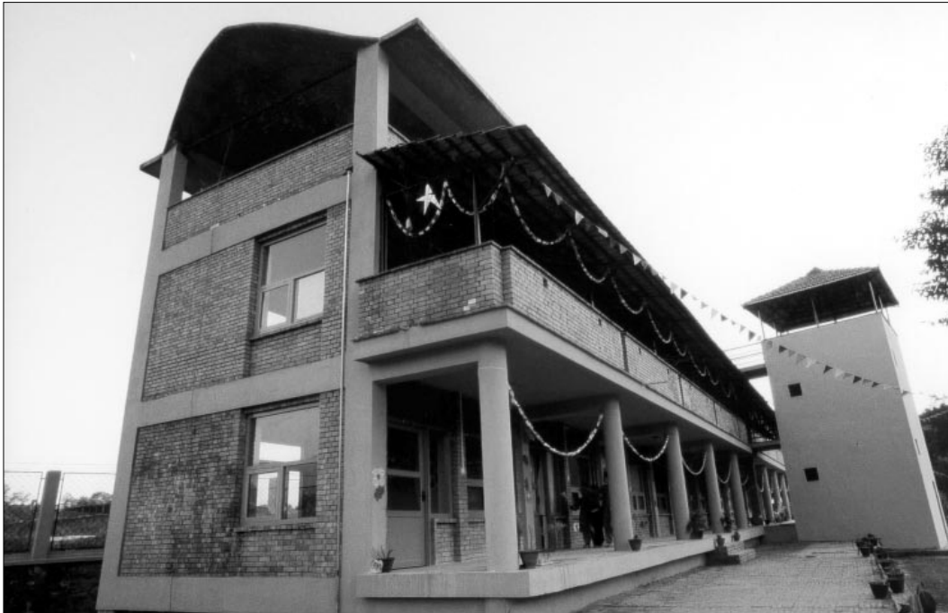
• L'Escola Catalunya construïda a Lambagar
