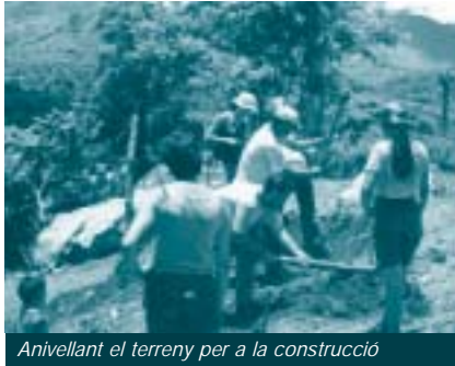
Anivellant el terreny per a la construcció
