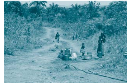
Punt d'aigua espontani a Kilembele durant les obres de construcció del tanc de distribució
