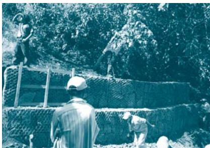
Obres d'estabilització a Pajales
