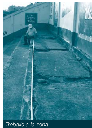
Treballs a la zona
