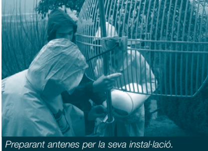
Preparant antenes per la seva instal·lació.
