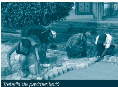
Treballs de pavimentació
