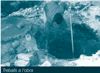
Treballs a l'obra
