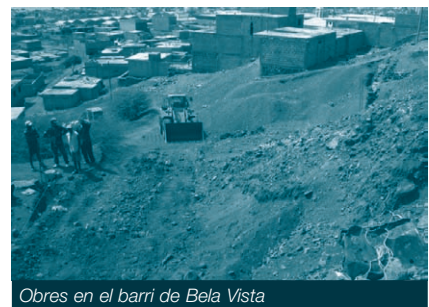
Obres en el barri de Bela Vista
