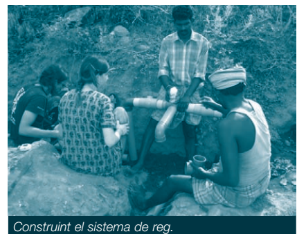
Construint el sistema de reg.
