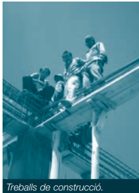
Treballs de construcció.
