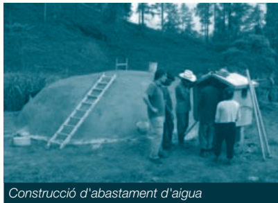
Construcció d'abastament d'aigua
