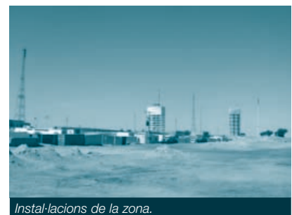
Instal·lacions de la zona.
