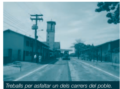
Treballs per asfaltar un dels carrers del poble.
