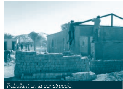
Treballant en la construcció.
