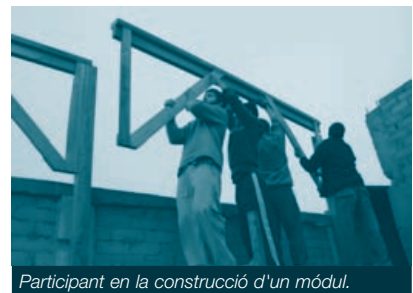
Participant en la construcció d'un mòdul.
