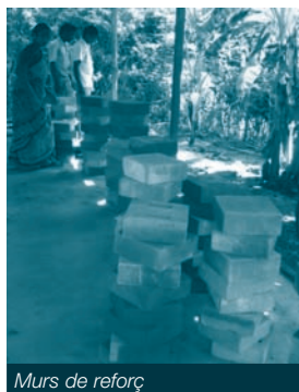
Murs de reforç
