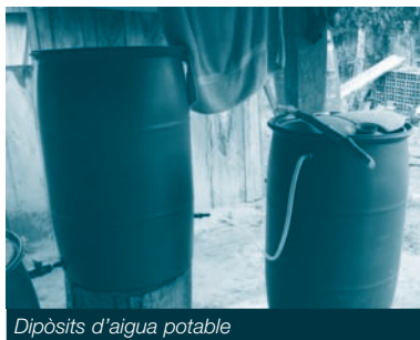
Dipòsits d'aigua potable
