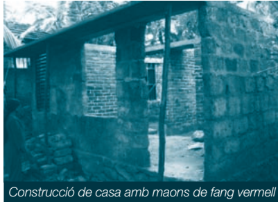
Construcció de casa amb maons de fang vermell
