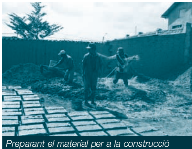
Preparant el material per a la construcció
