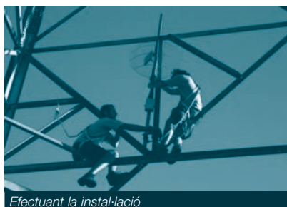
Efectuant la instal·lació
