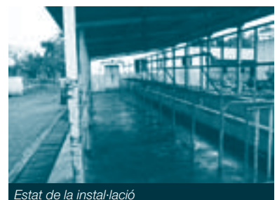
Estat de la instal·lació
