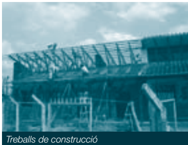
Treballs de construcció
