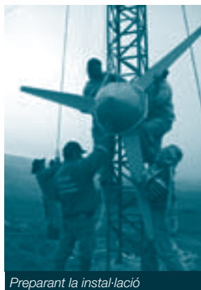
Preparant la instal·lació
