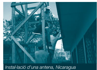
Instal·lació d'una antena, Nicaragua
