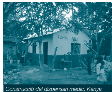
Construcció del dispensari mèdic, Kenya
