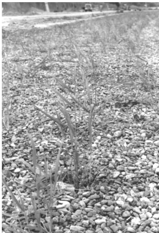
• Humedal subsuperficial: El agua residual circula por debajo de la grava
