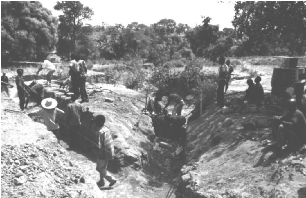
• Trabajos en el valle de Kambatiak
