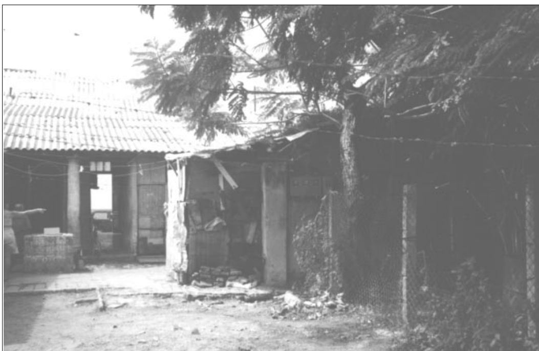
• Estado de las cuarterías
