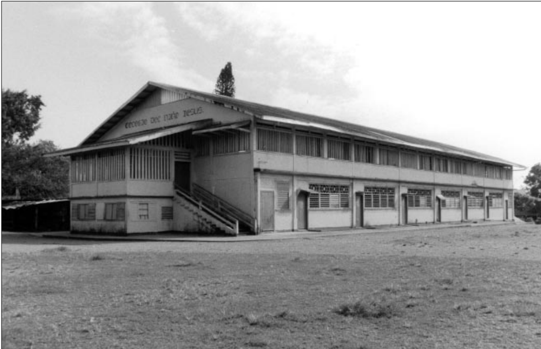
• Vista general de la escuela
