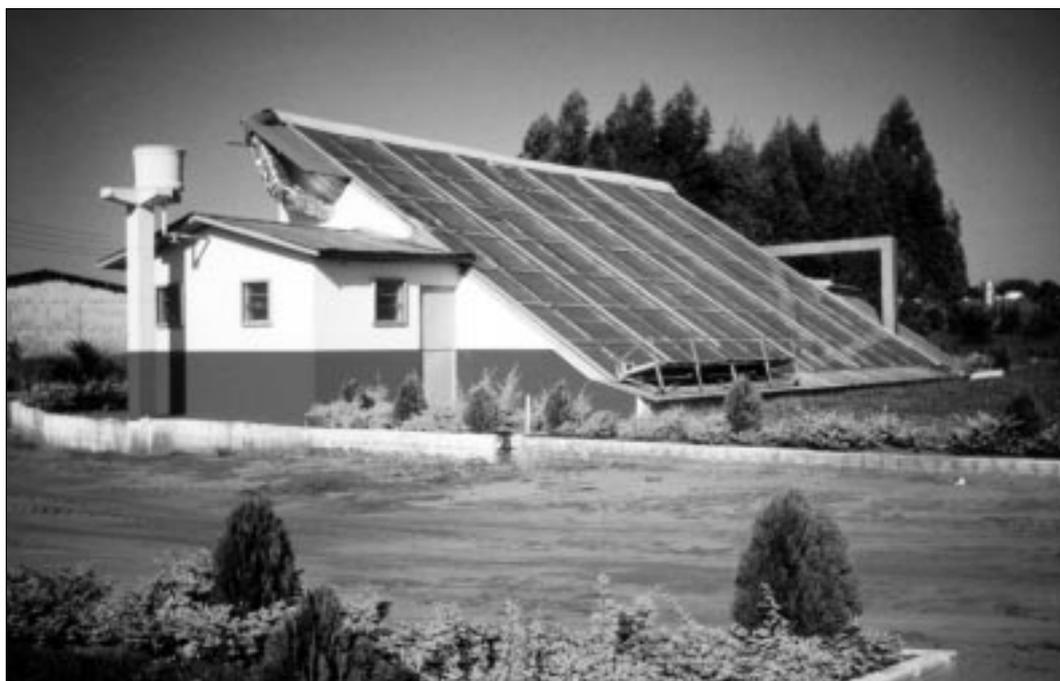
• Secadora de energía solar en Paraná
