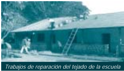
Trabajos de reparación del tejado de la escuela
