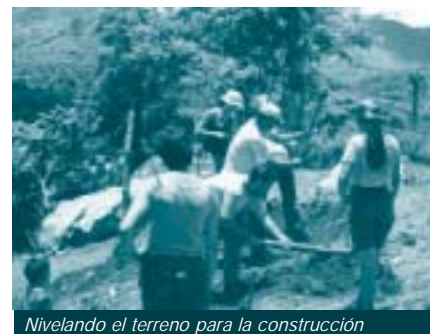
Nivelando el terreno para la construcción
