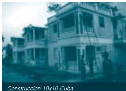
Construcción 10x10 Cuba
