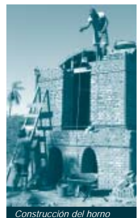
Construcción del horno
