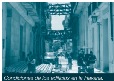
Condiciones de los edificios en la Havana.
