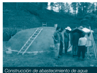
Construcción de abastecimiento de agua
