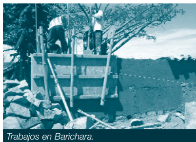
Trabajos en Barichara.
