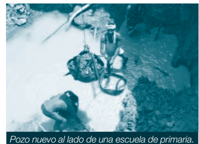
Pozo nuevo al lado de una escuela de primaria.
