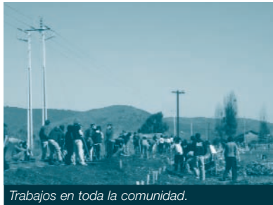
Trabajos en toda la comunidad.
