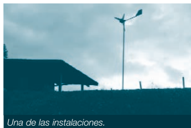
Una de las instalaciones.
