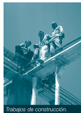
Trabajos de construcción.
