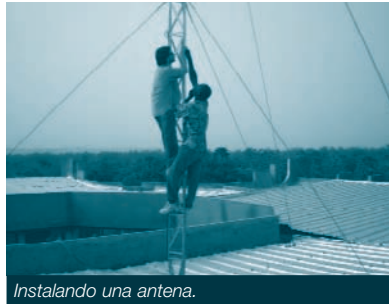
Instalando una antena.
