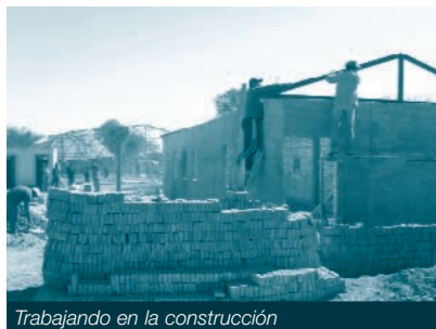
Trabajando en la construcción
