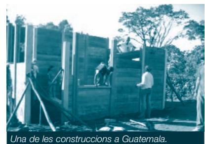
Una de las construcciones a Guatemala.
