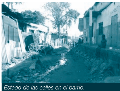
Estado de las calles en el barrio.
