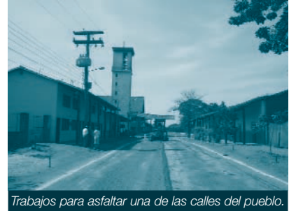
Trabajos para asfaltar una de las calles del pueblo.
