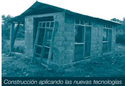
Construcción aplicando las nuevas tecnologías
