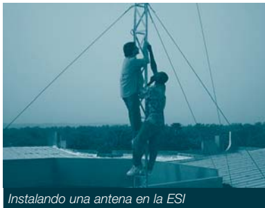
Instalando una antena en la ESI
