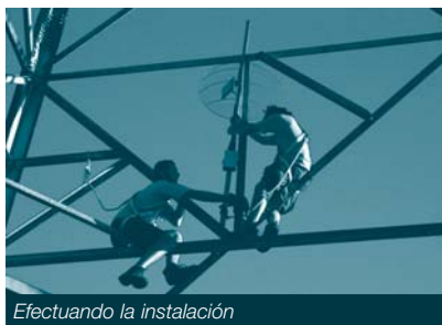
Efectuando la instalación
