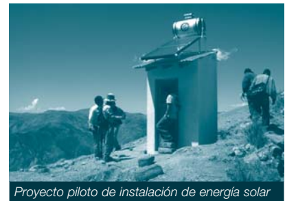
Proyecto piloto de instalación de energía solar
