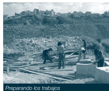
Preparando los trabajos
