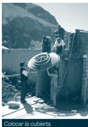
Colocar la cubierta.
