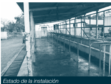
Estado de la instalación
