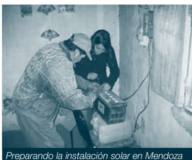
Preparando la instalación solar en Mendoza
