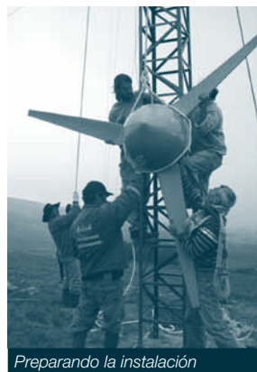
Preparando la instalación
