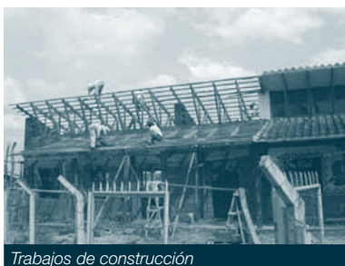
Trabajos de construcción
