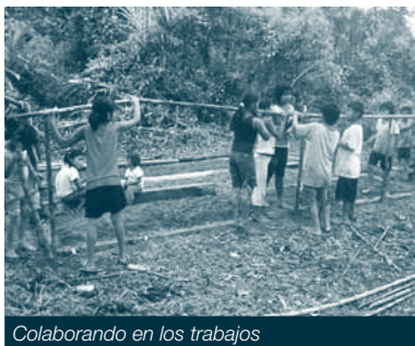
Colaborando en los trabajos
