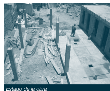
Estado de la obra
