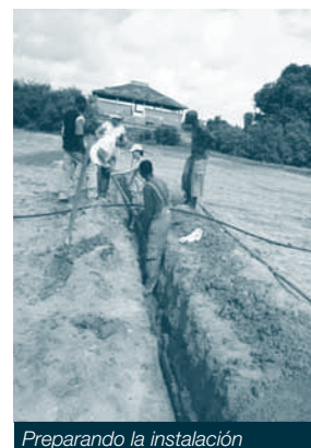
Preparando la instalación
