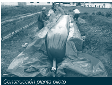
Construcción planta piloto
