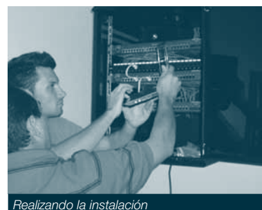
Realizando la instalación
