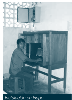
Instalación en Napo
