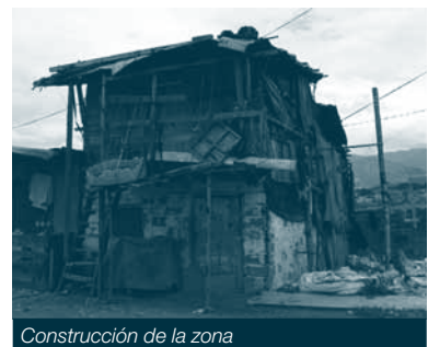
Construcción de la zona
