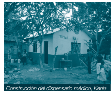
Construcción del dispensario médico, Kenia
