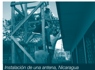
Instalación de una antena, Nicaragua
